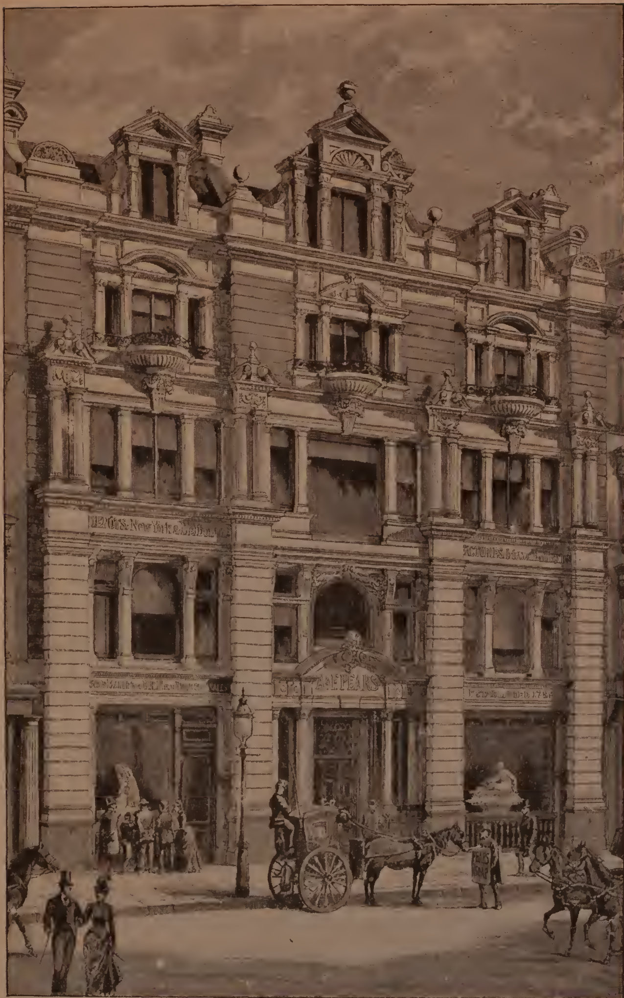
Façade des Bureaux de Messrs Pears, 71-73, New Oxford Street, Londres
